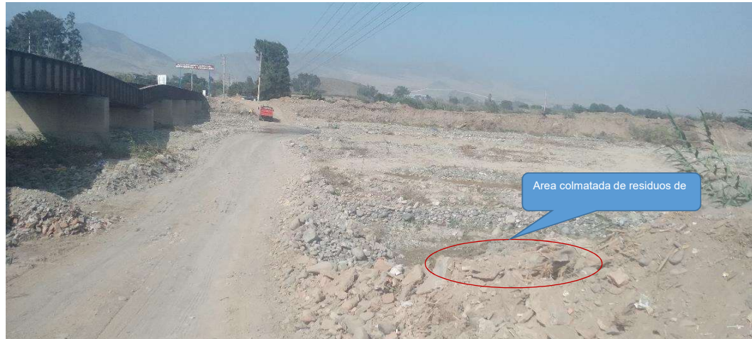
FIGURA N°01: RIO CHANCAY - HUARAL COLMATADO EN EL SECTOR PUENTE LA HUACA, CON LA PRESENCIA DE RESIDUOS DE CONSTRUCCIÓN Y OTROS, EN AMBAS MARGENES DEL RIO, OCASIONANDO LA REDUCCIÓN DEL ÁREA HIDRÁULICA SUSTANCIALMENTE, LA CUAL PRODUCE EL DESBORDE DEL RIO HACIA AMBAS MARGENES.
