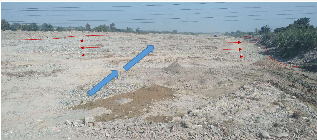
FIGURA N°03: TRAMOS EN EL MARGEN DERECHO DEL RIO CHANCAY - HUARAL CON DIQUES DE PROTECCIÓN DETERIORADOS, ESTO PROVOCA QUE LAS INUNDACIONES SEAN MAS INMINENTES EN EPOCAS DE AVENIDAS.
